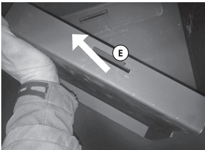
Darüber befindet sich die 3. Heizgasumlenkung. Sie ist hinten am Geräteturm ebenfalls in einer Bajonetthalterung eingehangen.
